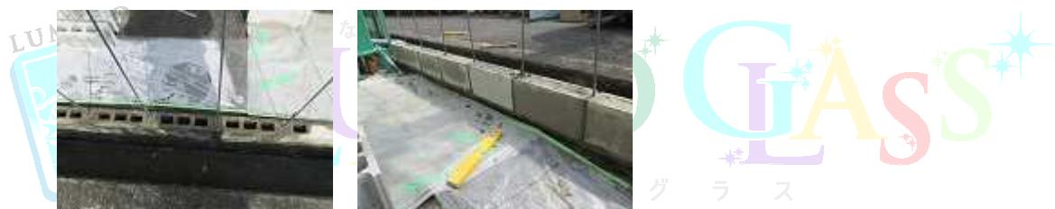
④ガラスブロックを積み上げていきます(本施工写真は立骨を使用しています)。
